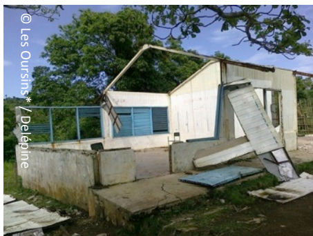
Ecole élémentaire à Tampipi, Samar Nord Reconstruction d'une école détruite par Haiyan sur une île isolée Budget : 20 000 €
