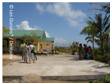
Construction d'une ludothèque à Basud, Samar Nord Espace de jeu et d'apprentissage sous un préau en matériaux locaux Budget : 10 000 €
